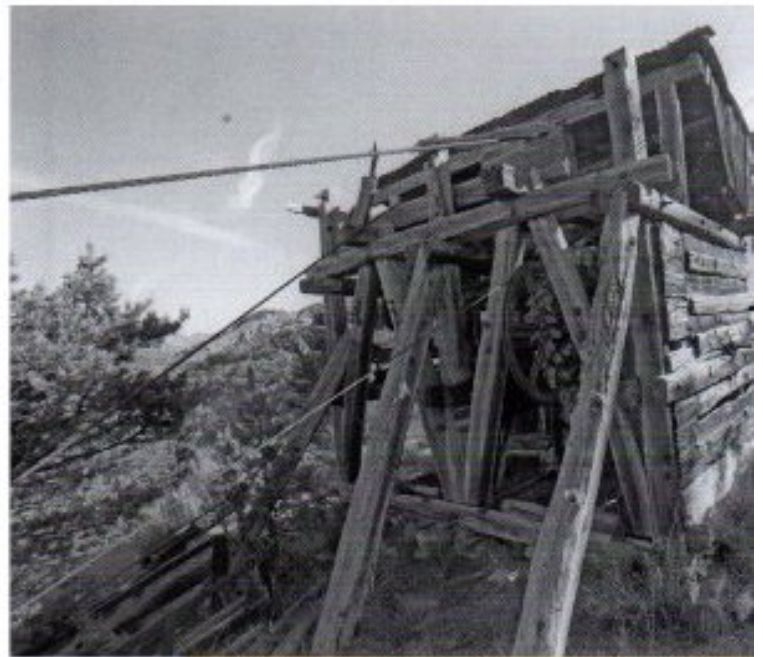
Ci-dessous : Câble à lait de Bouchannières. Imaginé en 1908, achevé en 1923, électrifié en 1936. Il a cessé de fonctionner dans les années 1980. Fonds Roudoule.
