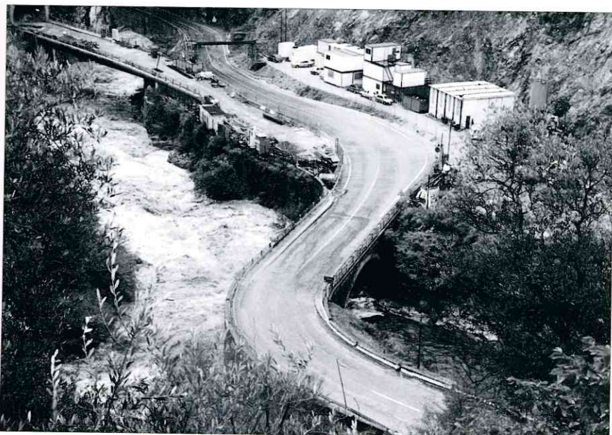
La mise en chantier prochaine du tunnel amont de Saorge devrait permettre son ouverture en 2003. D'ici là, les usagers devront redoubler de prudence à la sortie nord du tunnel aval, dont le raccordement à la route actuelle s'effectue suivant un tracé en S particulièrement sinueux. Par ailleurs, d'autres chantiers pour la mise à niveau de la RN 204 devront être entrepris, car le trafic routier, notamment celui des poids lourds, connaît une croissance spectaculaire dans la Roya. Photos Michel BRAUN
