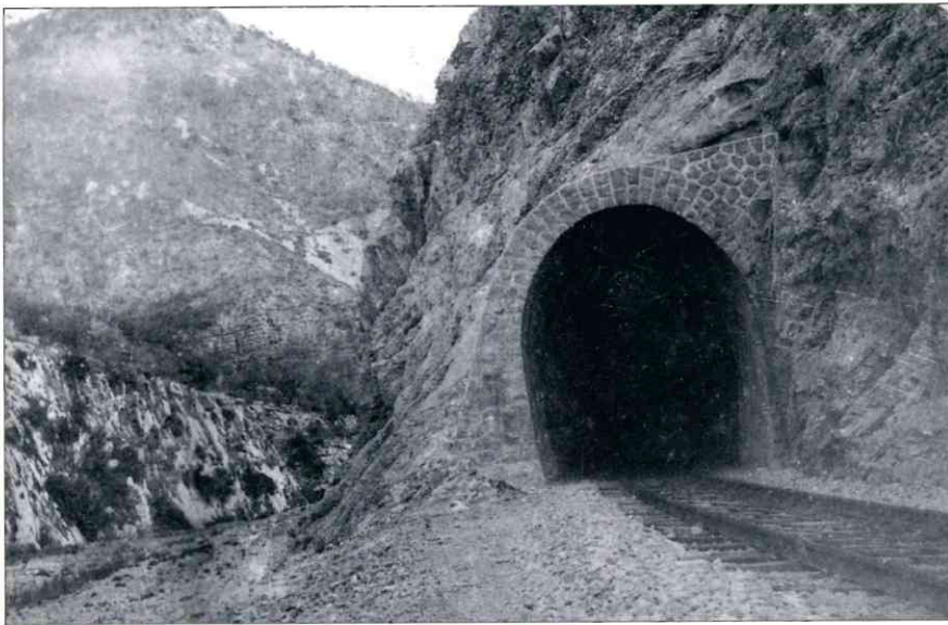
Ci-dessus : deux aspects de la déviation provisoire mise en service en novembre 1940 par le génie militaire italien pour rétablir la circulation des trains à la traversée de la Bévéra. A droite, la culée côté Breil du pont à travée métallique Roth-Wagner ; à gauche, l'entrée côté Sospel du tunnel en courbe et contre-courbe de 200 m de rayon. Collection Michel BRAUN
