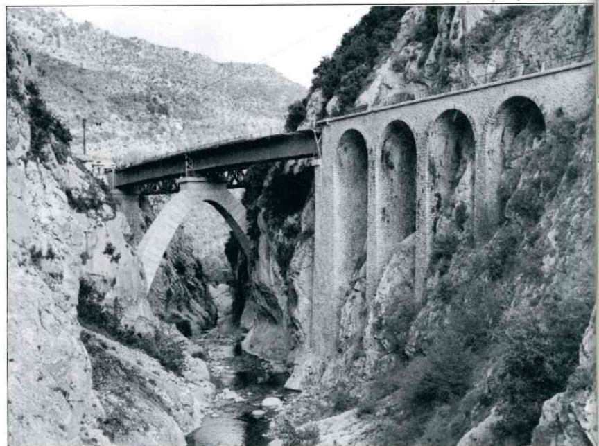
Ci-contre : un train de marchandises Breil - Nice débouche du tunnel de la déviation en avril 1954. Ci-dessous : la reconstruction du viaduc de la Bévéra sur une arche en béton à son emplacement d'origine, état des travaux en octobre 1961. Photo Jacques HARDEL & collection EUPHRASIE
