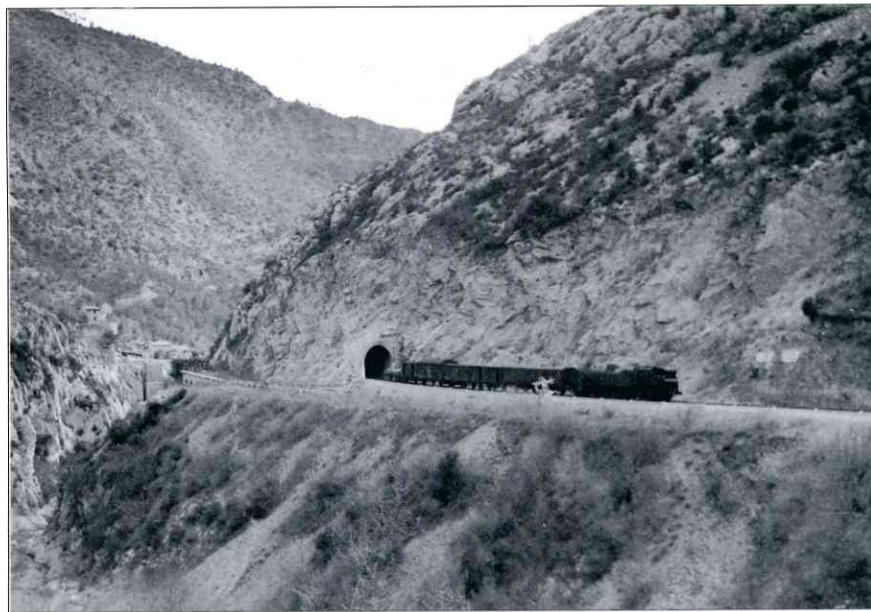
Ci-dessus : deux aspects de la déviation provisoire mise en service en novembre 1940 par le génie militaire italien pour rétablir la circulation des trains à la traversée de la Bévéra. A droite, la culée côté Breil du pont à travée métallique Roth-Wagner ; à gauche, l'entrée côté Sospel du tunnel en courbe et contre-courbe de 200 m de rayon. Collection Michel BRAUN
