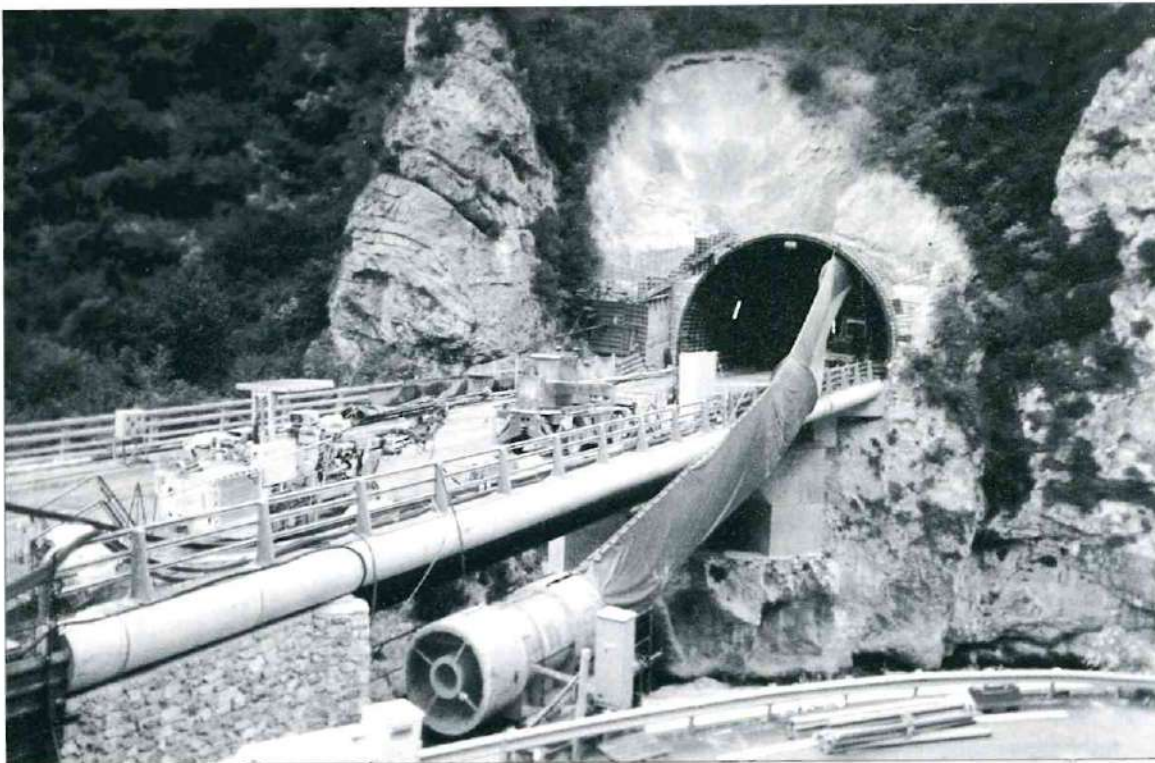
Le chantier du tunnel de Saorge côté nord en juillet 1999. Photo Michel BRAUN
