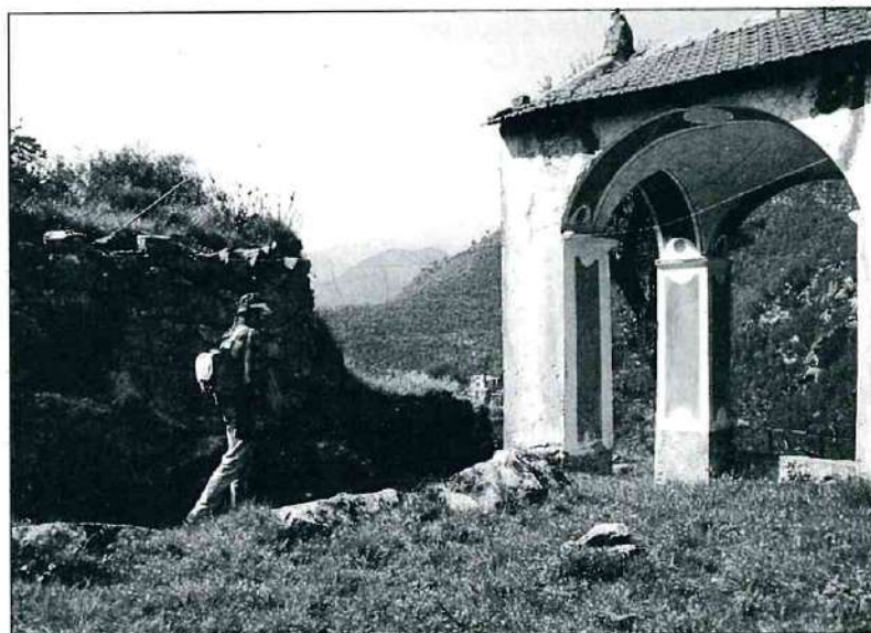
L'auvent de la chapelle San Bernardo à Airole, avant sa destruction par le tremblement de terre du 21 avril 1995. Photo Olivier KOOT
