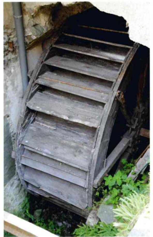
Ci-contre à droite, la roue principale de 2,50 m à pales en bois entraînant les deux meules du moulin à farine. Photo José BANAUDO
