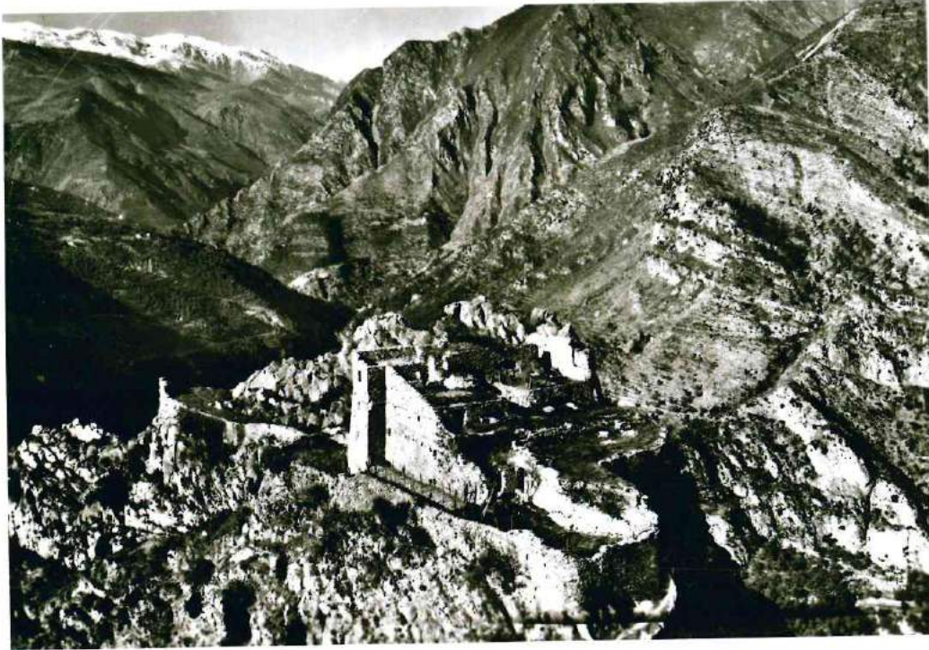
Les vestiges de l'ancien château de La Penna (Piène), qui domine la rive droite de la Roya en aval de Breil, sont évoqués dans le rapport du chef de bataillon Séré de Rivière. Collection Armand OLIVIERO
