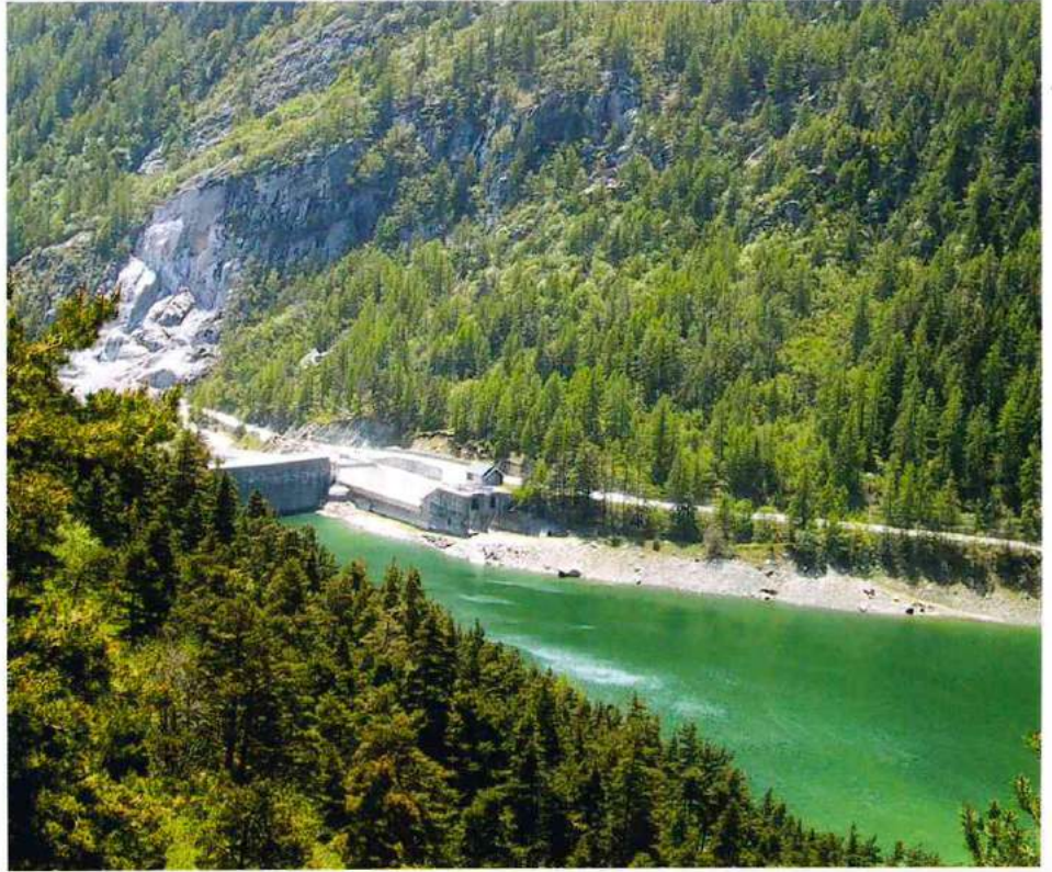
A gauche : l'éboulement sur la route nationale 91.
