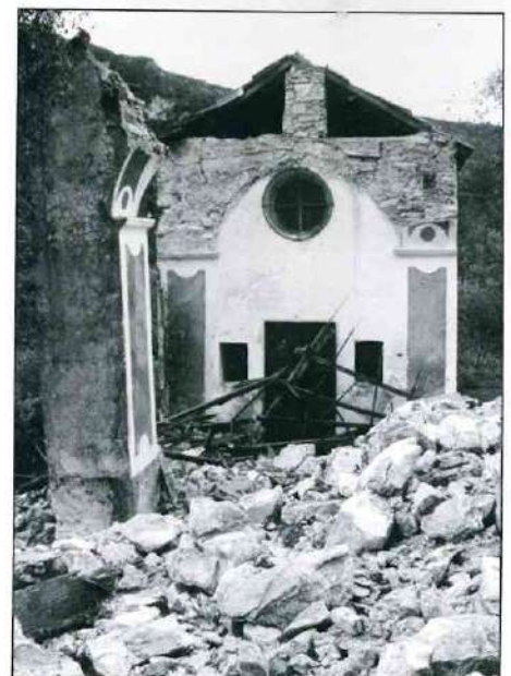
La secousse du 21 avril 1995 a été suffisamment forte pour faire basculer l'auvent de la chapelle San Bernardo.
