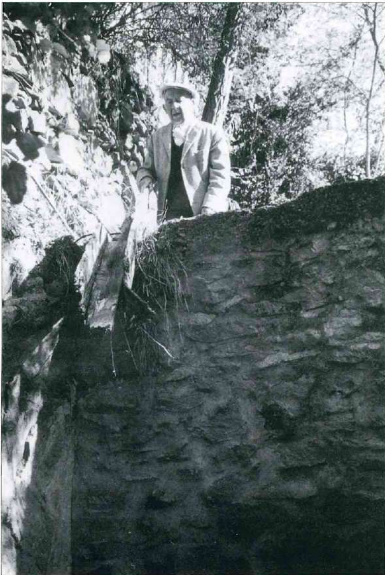
Désiré AST, ancien ouvrier, montre les vestiges de la rigole en bois qui charriait le sable à la 1ère chambre de la sablière. Photo Luigi MASETTI
