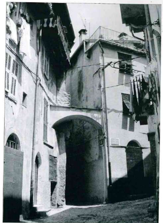
Trois photos de divers arcs de confortement dans les ruelles du village de La Brigue. Ci-dessus à gauche la ruelle Saint-François à La Brigue.
