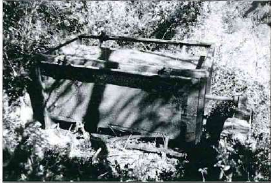
Près de la sablière Rollando : Le tamis de centrifugation du sable, alimenté par l'eau du canal. Photo Luigi MASETTI
