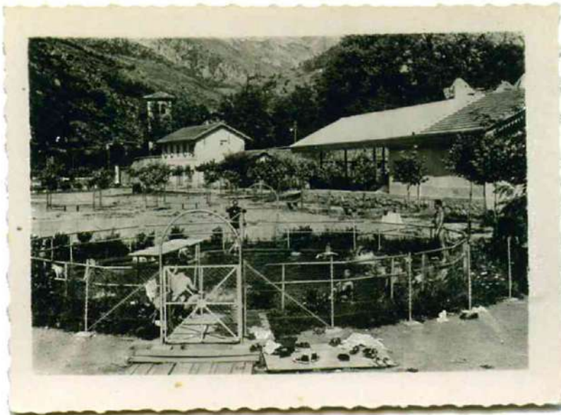
A gauche : le bassin de natation était aménagé dans la fosse du pont tournant qui servait à tourner les locomotives à vapeur italiennes, du temps où la gare de S.Dalmaz-zo-di-Tenda était le terminus de la voie ferrée entre 1915 et 1928.
