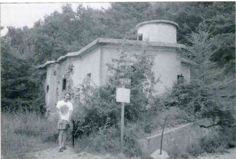
La station de tir telle qu'elle se présente aujourd'hui avec, sur le côté droit en hauteur, le poste simulant les conditions de tir d'une cloche sous béton. A gauche se trouvait le pas de tir destiné aux canons de 25 et 37 de montagne. Photo Jean-Pierre GARACIO
