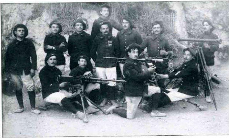
Une section de mitrailleuses du 27 ème B.C.A. équipée du modèle Hotchkiss refroidi par air. Pour les «puristes», voici quelques caractéristiques de cette arme: calibre 8 mm, longueur 1310 mm, poids à vide 25 kg. Elle possédait un magasin de 30 cartouches montées sur une bande métallique rigide, cadence de tir 450 coups/minute, vitesse du projectile au départ 725 mètres/seconde. Quelques exemplaires de cette arme seront encore en service dans l'armée anglaise lors des combats de la libération de 1944-45. L'appareil visible tout à droite est un binoculaire d'artillerie, sorte de jumelle d'observation à grand champ pour déterminer les paramètres de tir. Collection Jean-Pierre GARACIO
