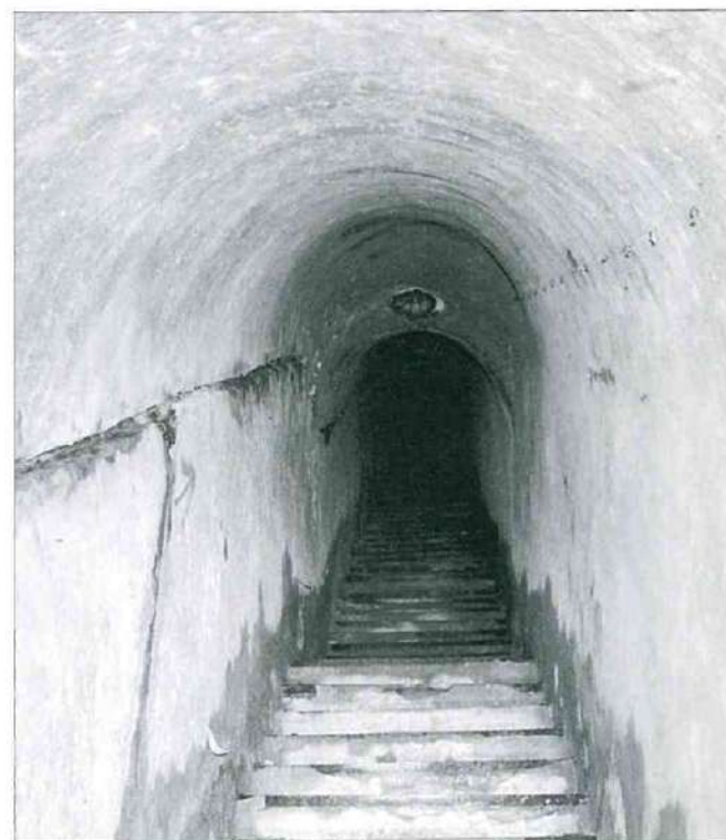
Ci-dessous, l'impressionnante volée d'escaliers reliant le 1er au 2ème niveau du fort des Balcons de Marta. Photos Yann DUVIVIER
