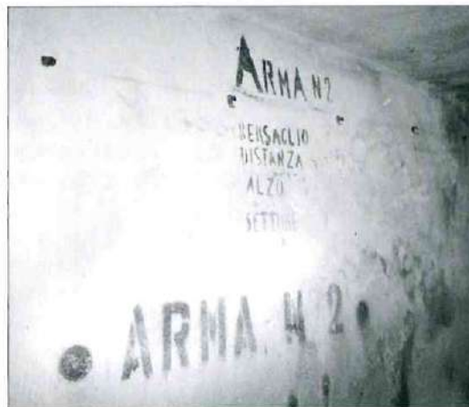
Ci-contre, inscriptions techniques pour la pièce n°2 d'une casemate: cible, distance, hausse et secteur.
