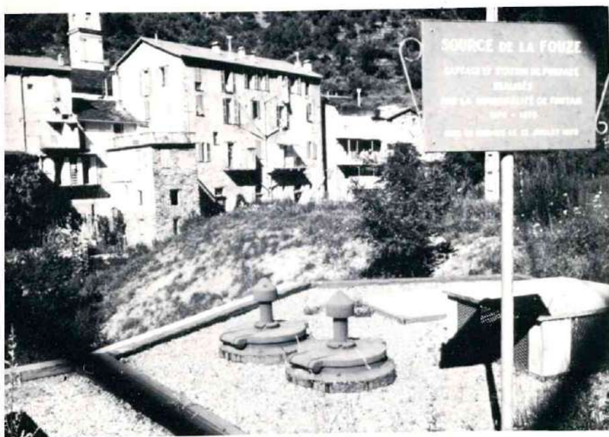
Ci-dessus, la station de pompage des eaux de Fontan. Photo Gérard FABRE
