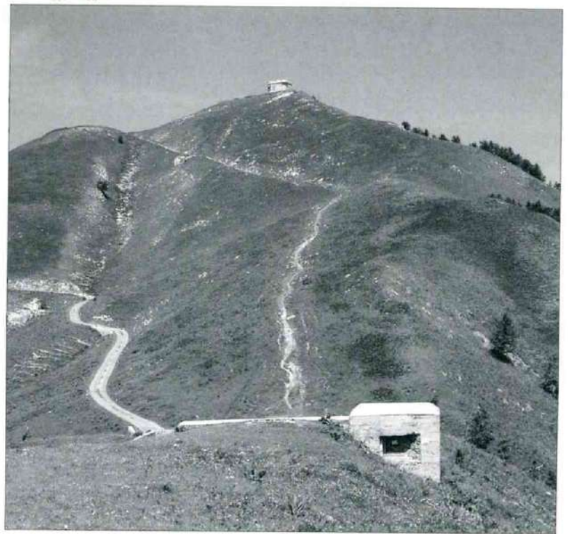
Authion: l'ouvrage de Plan-Caval n'était pas terminé en juin 1940. Le blockhaus au premier plan fut alors construit hâtivement pour protéger le sol français de l'attaque italienne. Finalement, seules les troupes allemandes l'utilisèrent en 1945. Au fond, on distingue l'ouvrage construit en 1897 de la Pointe des Trois Communes et la piste militaire empruntée par les chars français en 1945. Photo Yann Duvivier
