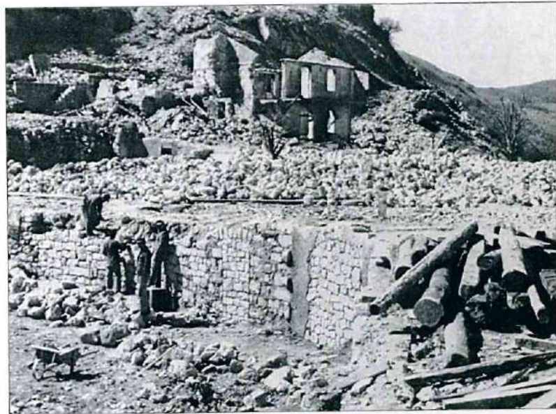
Le village de Castillon en 1947 durant le chantier de démolition des ruines. Collection Pierre Millo
