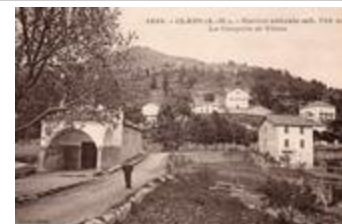
3899 - Clans (A.-M.) - Station estivale (alt. 700 m.) - La chapelle et Villas (06042-IM-00909)
