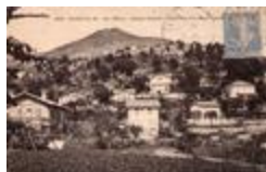
3625 - CLANS (A.-M.), Alt. 700 m. - Station estivale - Les villas et le Mont Castéou (06042-IM-00908)
