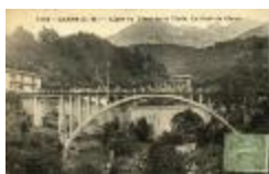
3462- Clans (A.-M.) - Ligne du Tram de la Tinée. Le Pont de Clans. (06042-IM-00001)
