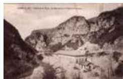
Clans (A.-M.) - Vallée de la Tinée - Le Bancairon et l'usine électrique (06042-IM-00903)
