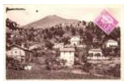
3625 - Clans (A.M.) - Altitude 700 m. - Station estivale - Les villas et le Mont Castéou (06042-IM-00906)
